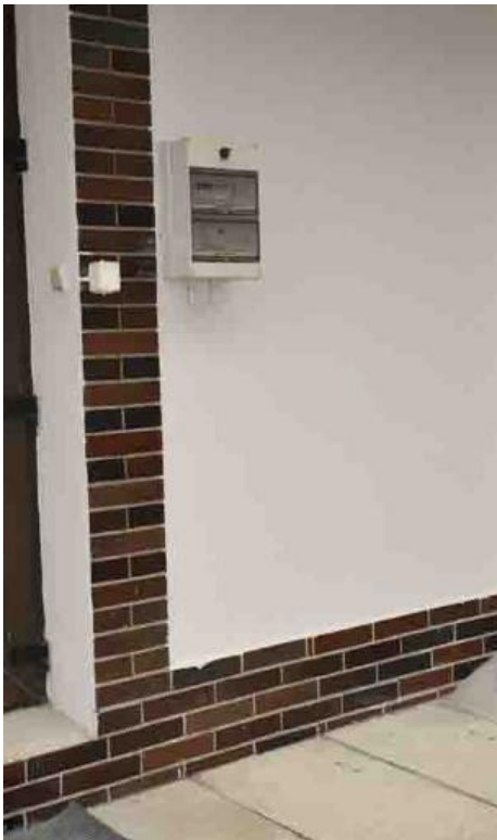
Obrázek F6-1: Elektrický rozvaděč s krytím IP 55
